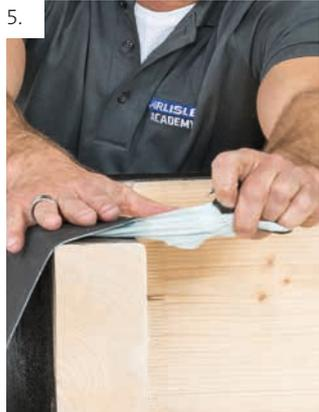
Rückseitige Schutzfolie abschnittsweise (von Bereich a bis d) entfernen und Dachbahn mit Attika verkleben.
