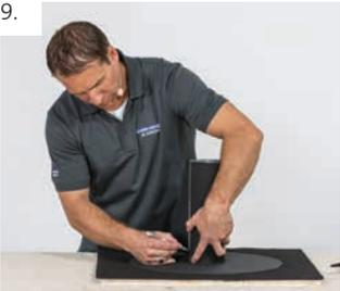
Abwicklung Rohr + 50 mm Überdeckung zuschneiden.
