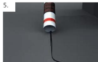
Der überschüssige Kleber KS 96 wird danach z.B. mit der Rückseite einer leeren Kartusche sauber abgetragen.
