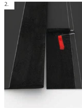
Die zu überlappende Seite ist wie zuvor beschrieben ebenfalls zu markieren. KS 137 wird 80 mm auf beiden Seiten mit Pinsel/Farbwalze gut deckend aufgetragen. Die äußere 20 mm breite Nahtkante bleibt frei.
