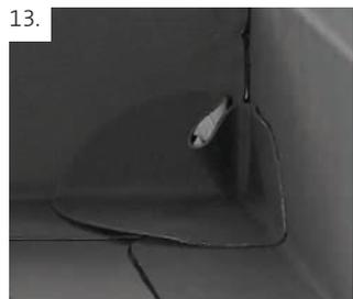
Stanzteil faltenfrei ansetzen und vollflächig verschweißen.
