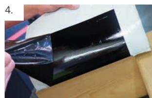
4. Abschnittsweise (von Punkt a bis d) entfernen und mit Baukörper verkleben sowie mit einer Andrückrolle in die Ecke einarbeiten.
