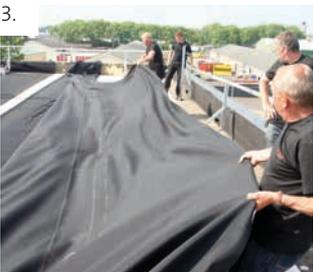
HERTALAN® EASY COVER Plane ausrollen und anschließend ausrichten.
