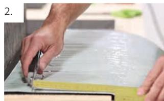
Die Abmaße der Attikaabwicklung auf der rückseitigen Schutzfolie mittels Zollstock und Cuttermesser vorsichtig auf die Schutzfolie übertragen – siehe Abbildung unten.
