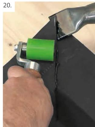
Restliche Schutzfolie abziehen und Attikakrone faltenfrei aufkleben/anrollen. Abschließend im Überdeckungsbereich (Attikakrone) mit Heißluft verschweißen.
