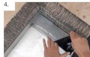
Den zweiten Anschlussstreifen bis in die Ecke führen. Im Bereich der Attika die Folie entfernen, den Anschlussstreifen auf die Quetschfalte aufkleben und faltenfrei anrollen.
