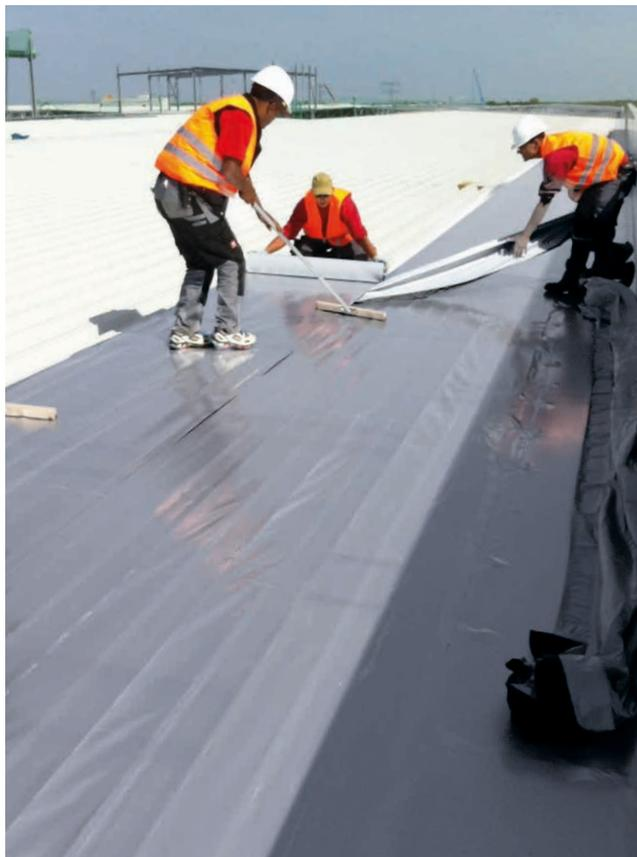
1. ALUTRIX® mit einer Überdeckung von 50 mm ausrollen.
