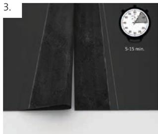
Nach einer Abluftzeit von ca. 5 - 15 Minuten (Fingerprobe durchführen) die Überlappungen spannungs- und faltenfrei aufeinanderlegen und ohne Luftblasen fest anrollen.
