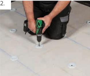
Die Halteteller entsprechend dem Verlegemuster anbringen. Bei Untergründen mit einem niedrigen Schmelzpunkt (z.B. Polystyrol) ist ein zusätzlicher Schutzsteller zwischen Halteteller und Untergrund zu platzieren. Die Oberseite der Halteteller muss sauber und trocken sein!
