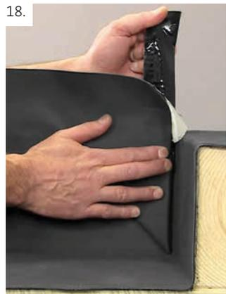
Anschlussstreifen gegen die heiße Bitumenmasse andrücken und anschließend Reststück nach oben herausziehen. »
