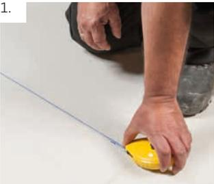
Anhand von Windlastberechnung und Herstellervorschriften für den Dämmstoff wird ein Verlegemuster für die Halteteller festgelegt.
