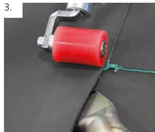
Beim Verschweißen kurzzeitig mit dem Schweißgerät verharren, um ein optimales Erwärmen der Schweißschnur zu gewährleisten.
