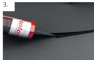
In die äußere, 20 mm breite klebefreie Überlappungszone wird KS 96 eingebracht.
