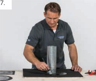
Den Kontaktkleber KS 137 bis zur 20 mm Außenkantenmarkierung auf der Flächenabdichtung auftragen.
