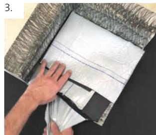
Anschlussstreifen sauber in der Ecke platzieren. Unterseitige Schutzfolie entfernen und aufkleben.
