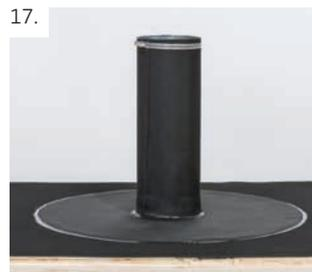
Oberen Abschlussbereich mit Hilfe eines Edelstahlschellenbandes hinterlaufsicher anschließen.
