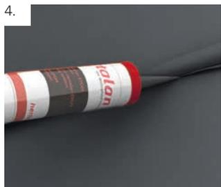
In die äußere, 20 mm breite klebstofffreie Überlappungszone wird KS 96 eingebracht.
