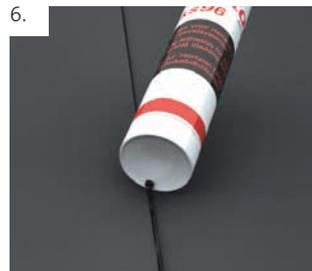
Der überschüssige Kleber wird danach z.B. mit der Rückseite einer leeren Kartusche abgetragen.
