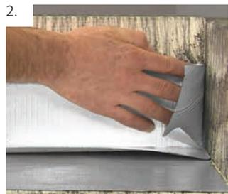
Ersten Anschlussstreifen genau in der Ecke platzieren, Trennfolie in der Vertikalen abziehen und vollflächig faltenfrei mit einer Silikonrolle anrollen.
