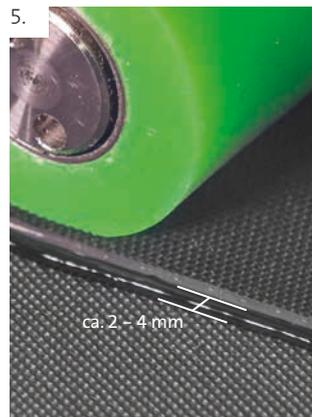
An der Bahnenkante muss eine sehr gut sichtbare Bitumenraupe von ca. 2 mm bis 4 mm austreten.
