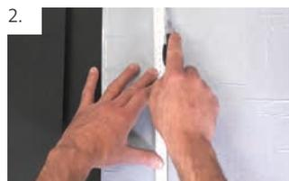
2. Die Abmaße der Attikaabwicklung auf der rückseitigen Schutzfolie mittels Zollstock und Cuttermesser vorsichtig auf die Schutzfolie übertragen – siehe Abbildung unten.
