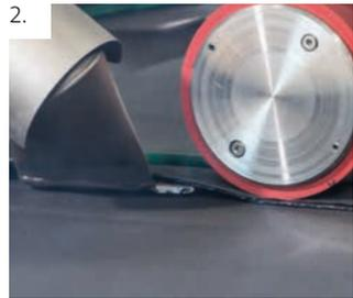
Bitumenraupe von ca. 2-4 mm muss seitlich austreten und garantiert so die 100 %ige Dichtigkeit der Schweißnaht.
