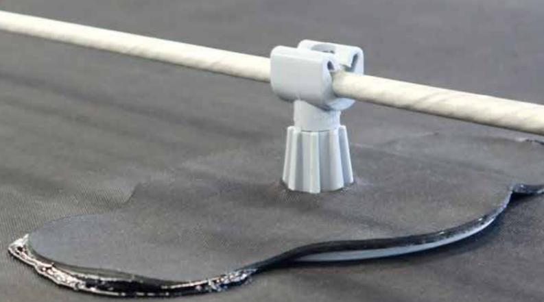
Das Haltersystem zur Führung und Befestigung von Blitzschutzleitungen hat einen Durchmesser von maximal 10 mm auf Flachdachkonstruktionen ohne Auflast. Das Haltersystem besteht aus einer runden Kunststoff-Grundplatte, Durchmesser 110 mm, mit aufsteckbarer und horizontal ausrichtbarer Führung für die Blitzschutzleitung. Es wird dachseitig mit einem überstülpbaren und aufschweißbaren Formteil aus RESITRIX® fixiert.
