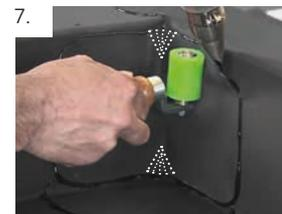
7. Formteil (Zunge) zunächst in den Eckbereichen (oben und unten) überdehnen (siehe Schraffierung). Anschließend die Zunge über die Quetschfalte im Abstand von 3 mm über der Dachdichtungsbahn platzieren und vollflächig verschweißen.
