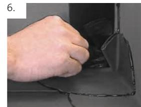
6. Schutzfolie im Bereich der Quetschfalte entfernen und diese mit Heißluft verschweißen. Quetschfalte mittels Bitumenabstrich an der Attika fixieren.
