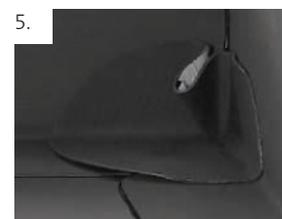
5. Stanzteil faltenfrei ansetzen und vollflächig verschweißen.
